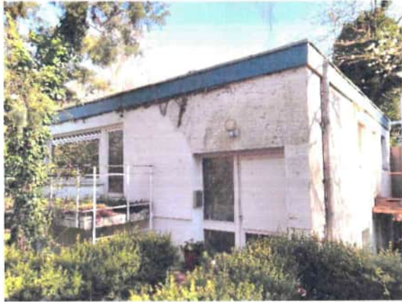
Foto 10: Außenansicht der Südwestfassade des Einfamilienhauses im Gartenbereich mit Flachdach (Gebäude G), Blickrichtung Nordost (09.04.2020).
