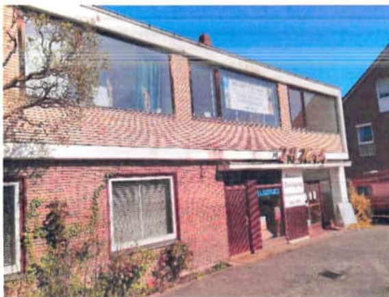
Foto 1: Außenansicht der Südostfassade der alten Blaudruckmanufaktur und Färberei (Gebäude A), Blickrichtung Nord (09.04.2020).
