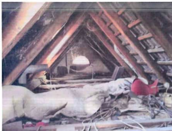
Foto 23: Innenansicht des Dachbodens des Gebäude F, Blickrichtung Südost (09.04.2020).
