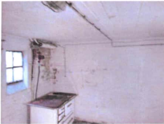
Foto 25: Innenansicht eines Kellerraumes des Gebäude F, Blickrichtung Südost (09.04.2020).
