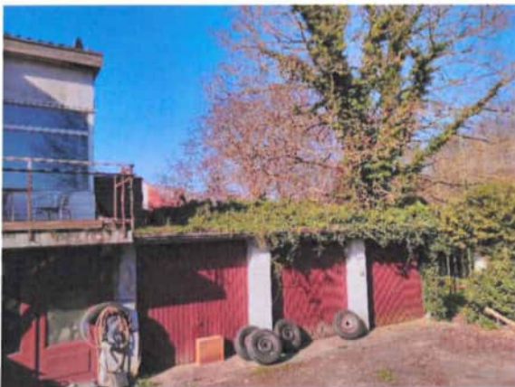
Foto 7: Außenansicht der Werkstatt mit Garagen (Gebäude D), Blickrichtung West (09.04.2020).
