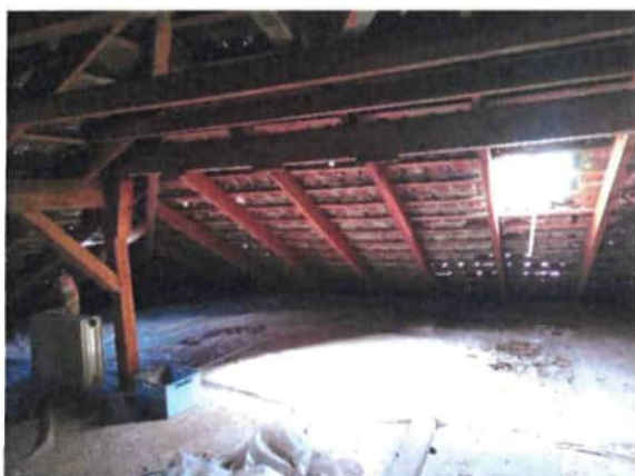
Foto 15: Innenansicht des Dachbodens des Gebäude A, Blickrichtung Südost (09.04.2020).
