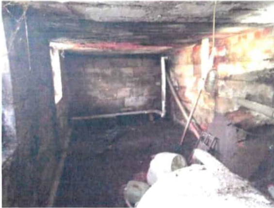
Foto 19: Innenansicht des Kellers des Gebäude B, Blickrichtung Ost (09.04.2020).
