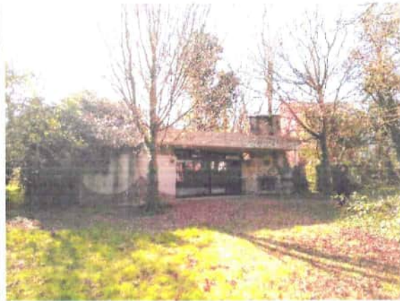
Foto 12: Außenansicht des gemauerten Gartenhauses im Gartenbereich im Nordteil des Plangebietes (Gebäude H), Blickrichtung Südwest (09.04.2020).
