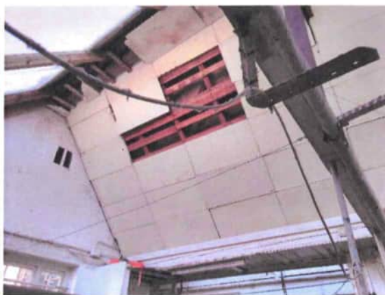
Foto 18: Innenansicht des Dachbereiches des Gebäude B, Detailansicht (09.04.2020).
