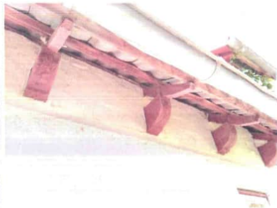
Foto 24: Ansicht der Dachtraufe mit Zugangsmöglichkeiten in den Dachraum des Gebäude F, Detailansicht (09.04.2020).
