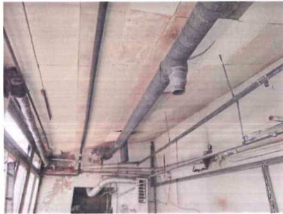
Foto 22: Innenansicht des Dachbereiches des Gebäude D, Detailansicht (09.04.2020).
