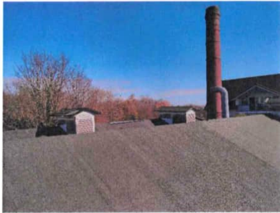
Foto 4: Außenansicht des Daches über der Werkhalle der alten Bladruckmanufaktur und Färberei (Gebäude B), Blickrichtung Nord (09.04.2020).
