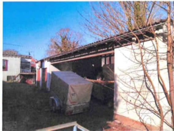
Foto 8: Außenansicht des Garagenkomplexes (Gebäude E), Blickrichtung Nordwest (09.04.2020).
