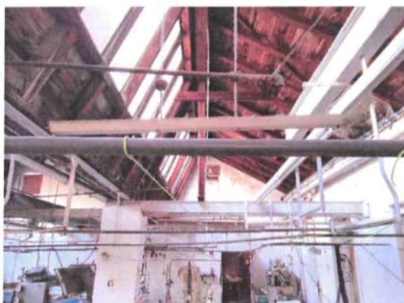
Foto 17: Innenansicht des Gebäude B, Blickrichtung Nordost (09.04.2020).
