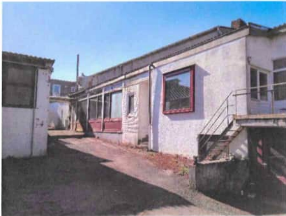
Foto 6: Außenansicht der Werkstatt der alten Bladruckmanufaktur und Färberei (Gebäude D), Blickrichtung West (09.04.2020).
